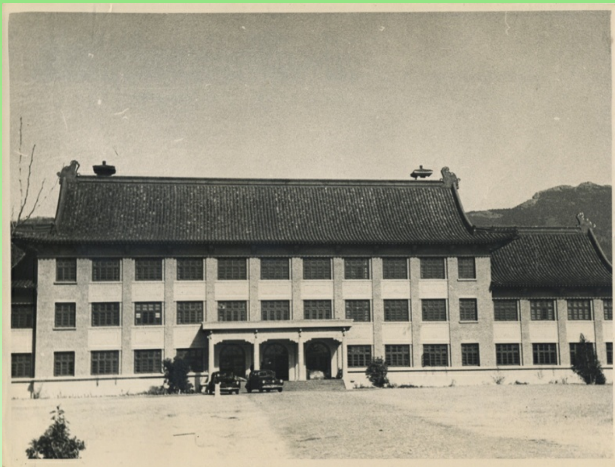
Лабораторное здание Нанкинского ботанического сада.
