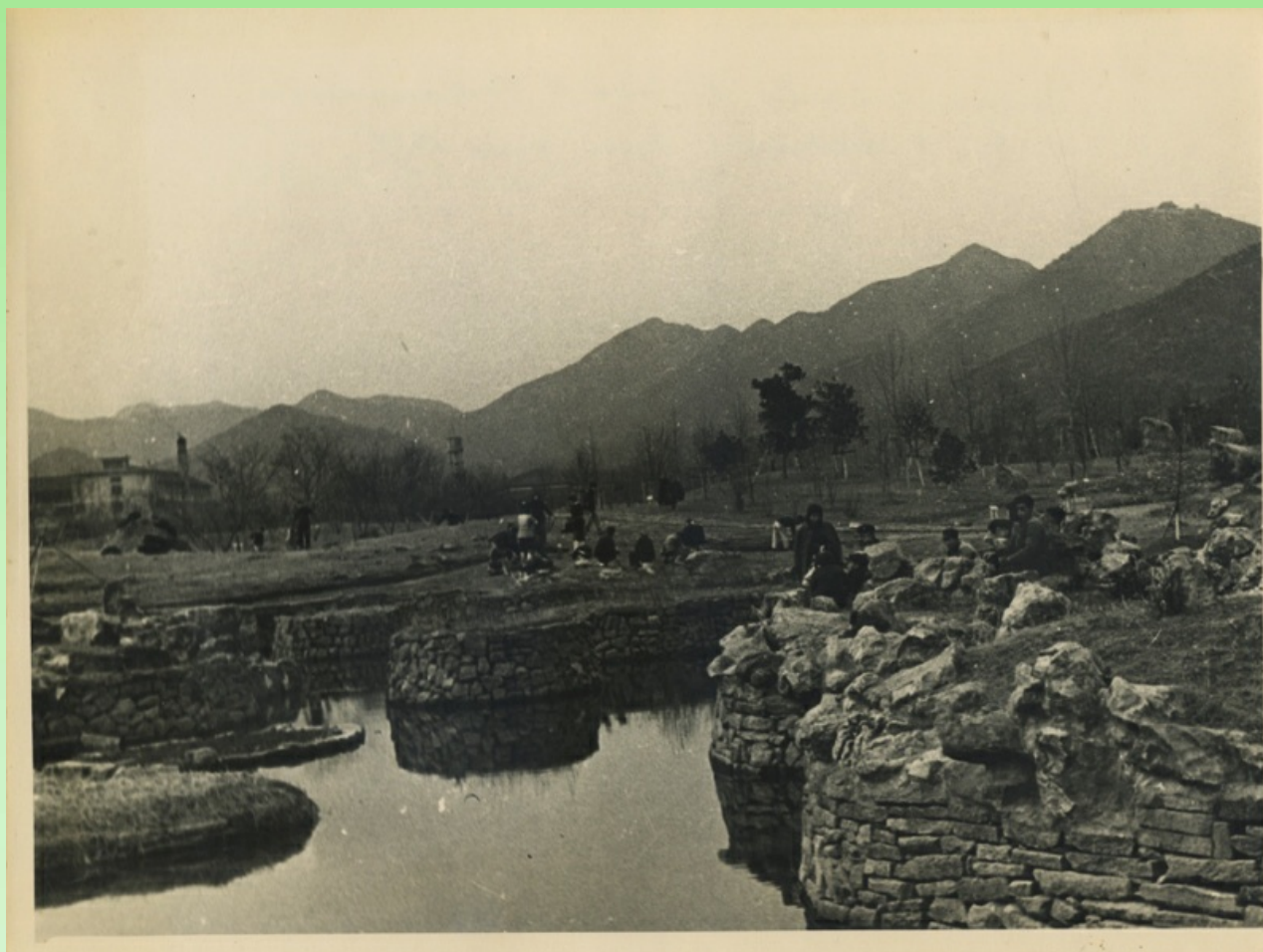
Строительство водоема в Ботаническом саду в Ханчжоу.
