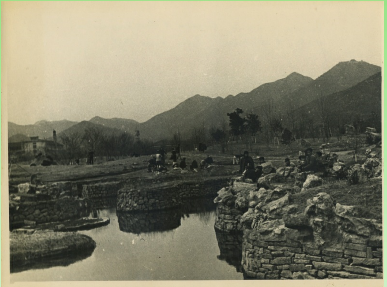
Строительство водоема в Ботаническом саду в Ханчжоу.
