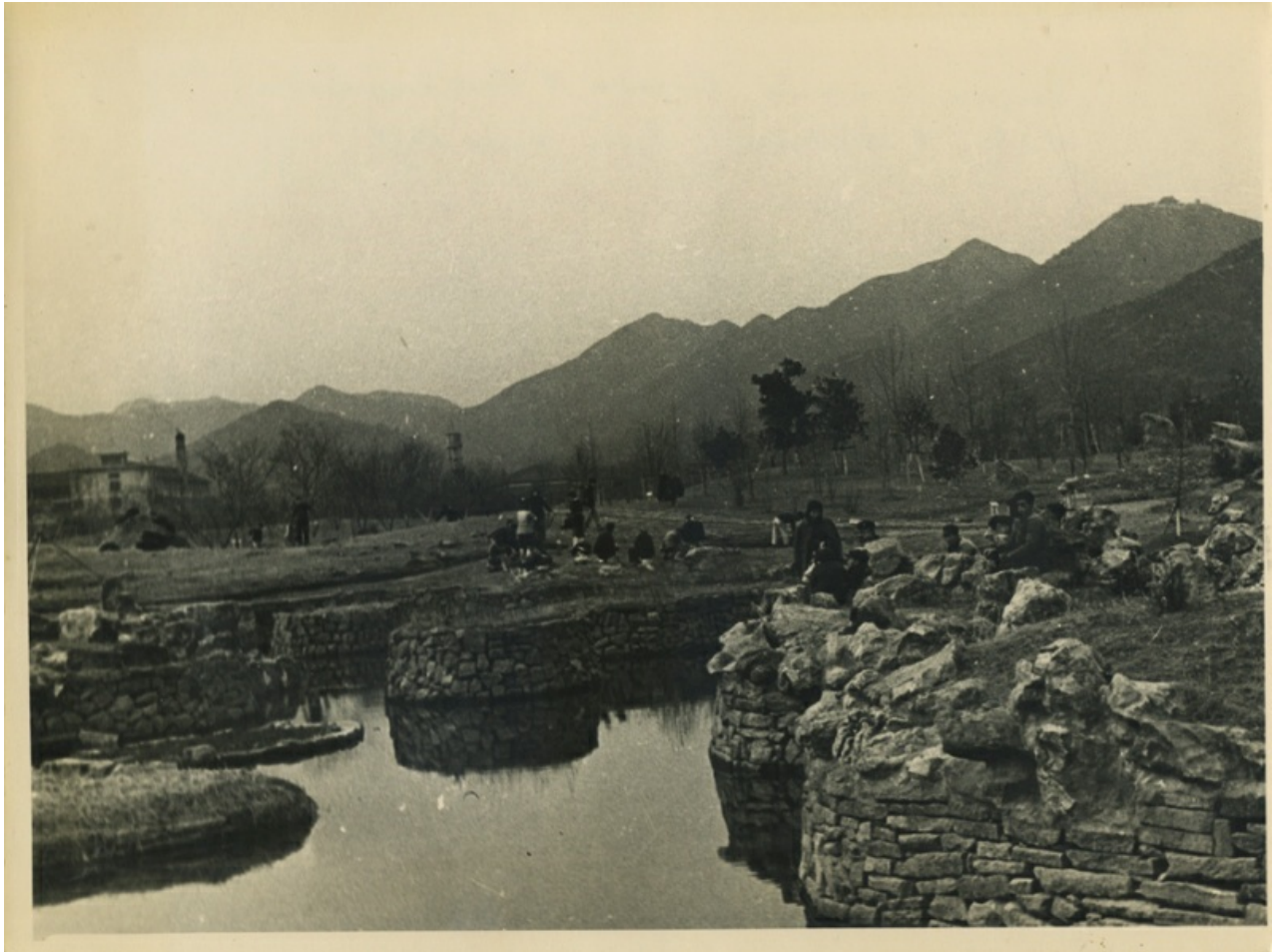
Строительство водоема в Ботаническом саду в Ханчжоу.
