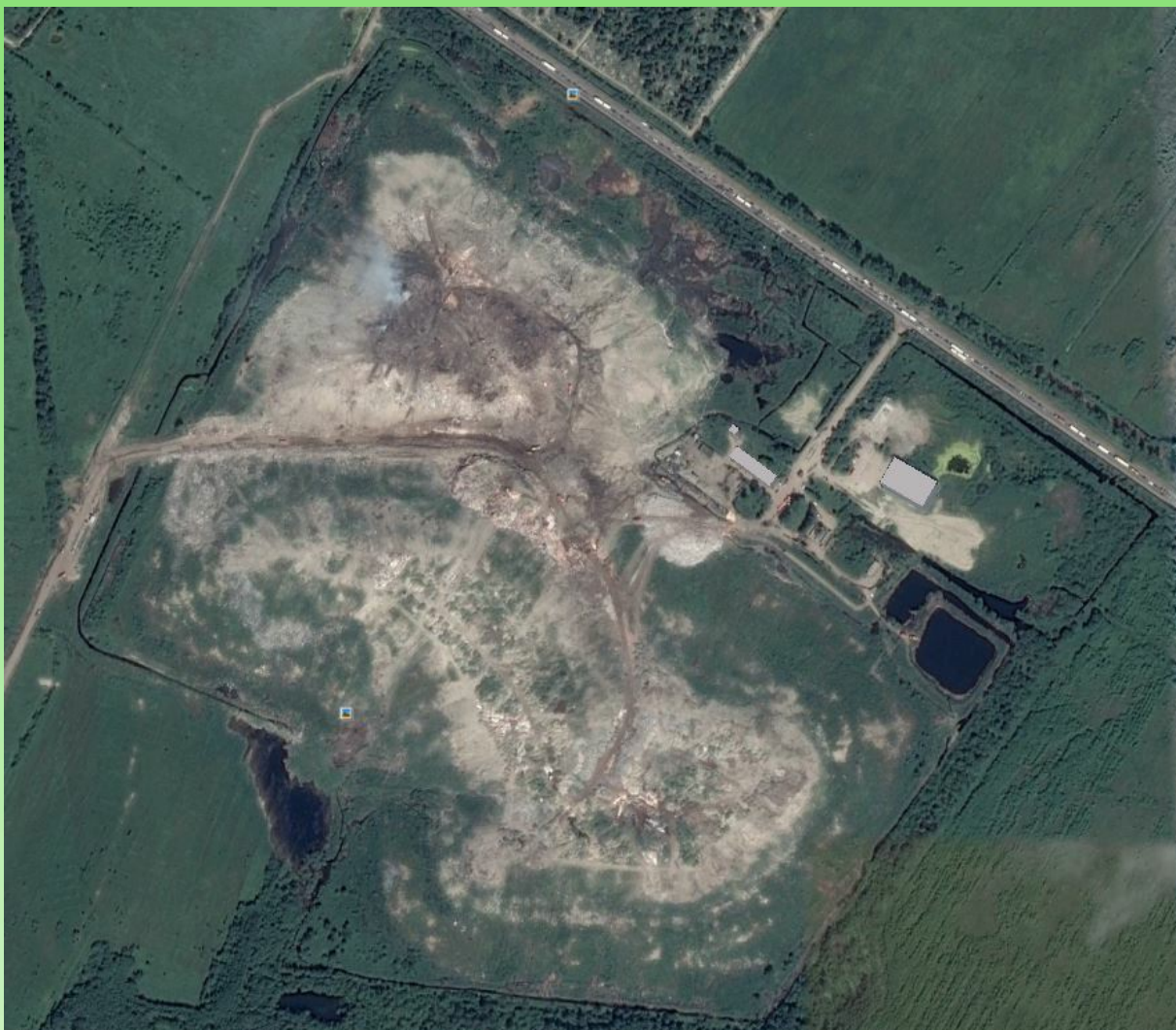
Рис. 1. Южный полигон ТБО вдоль Волхонского шоссе в окр. Пулковое (южные окраины Санкт-Петербурга), снимок из космоса (взято с «Google Earth» в 2018 г.).
