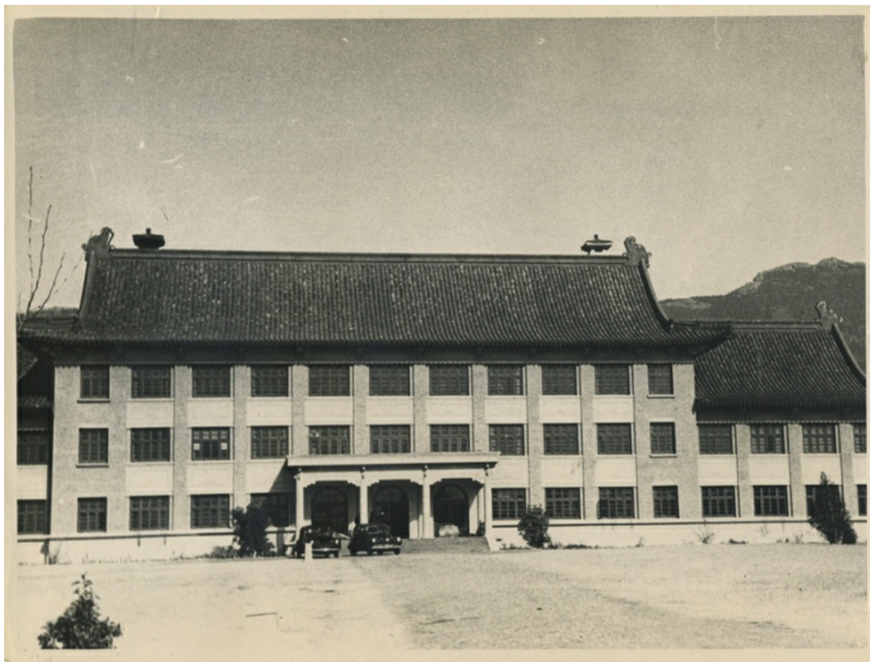
Лабораторное здание Нанкинского ботанического сада.
