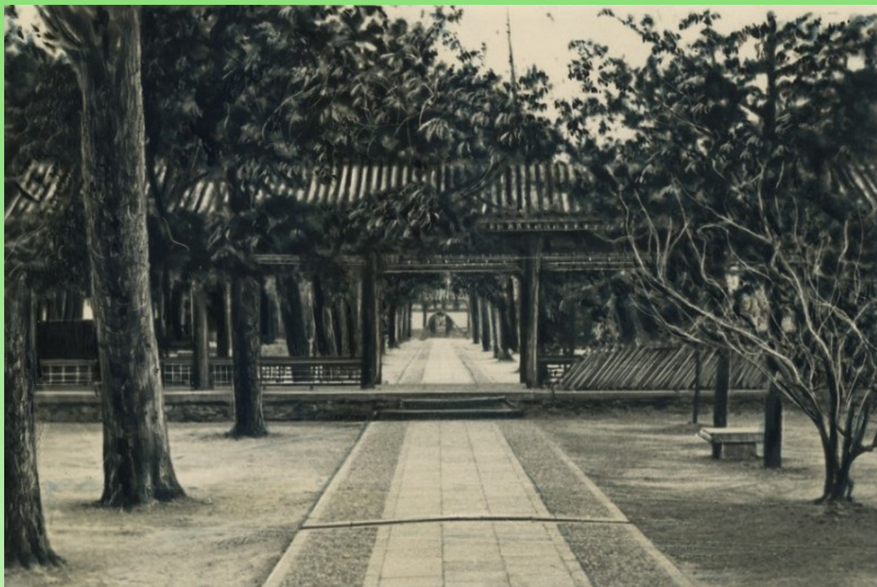
Крытая галерея в парке Ихэюань.
