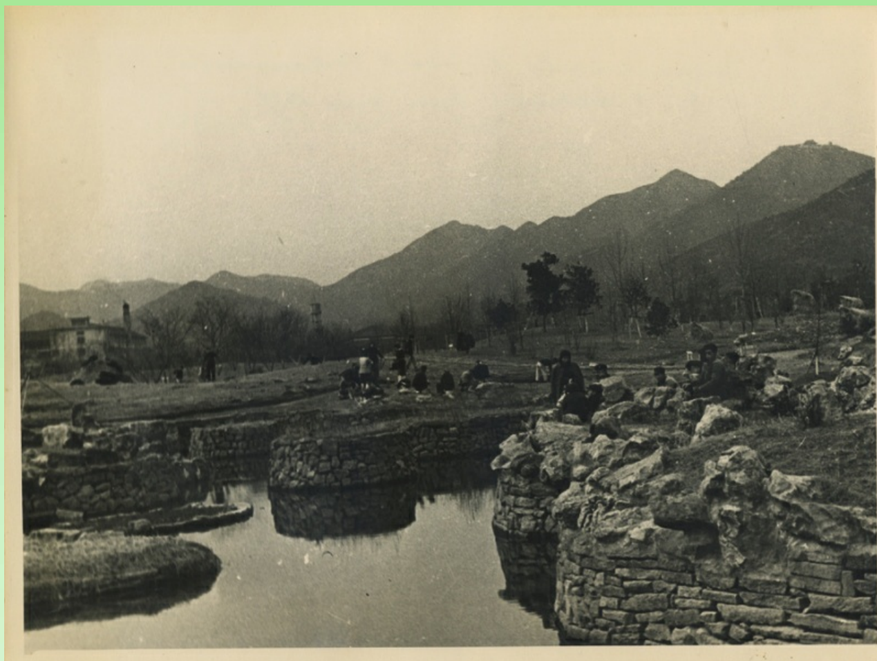
Строительство водоема в Ботаническом саду в Ханчжоу.
