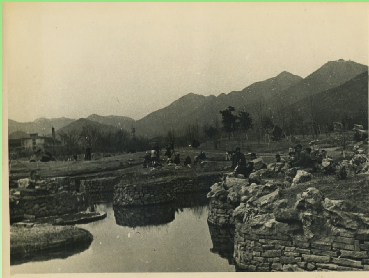
Строительство водоема в Ботаническом саду в Ханчжоу.
