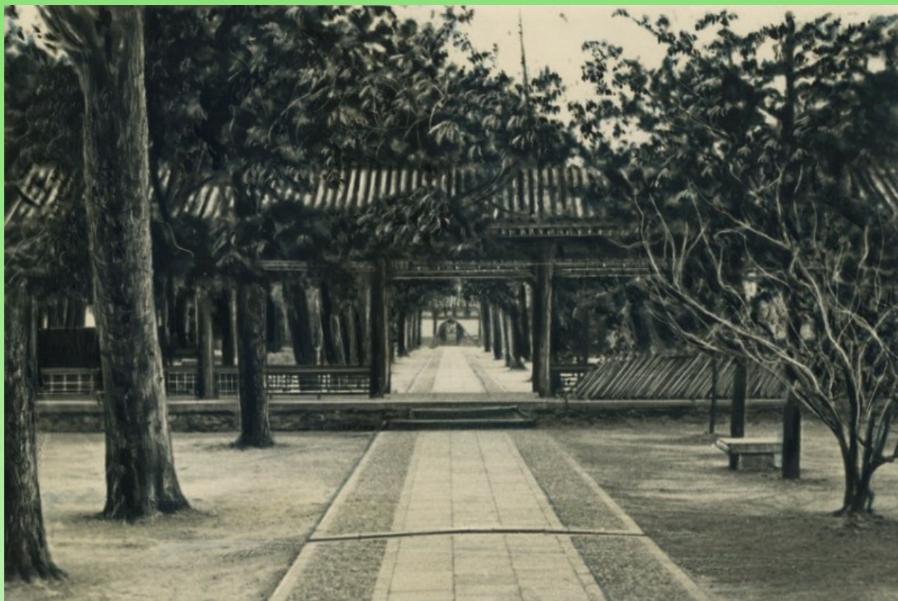
Крытая галерея в парке Ихэюань.
