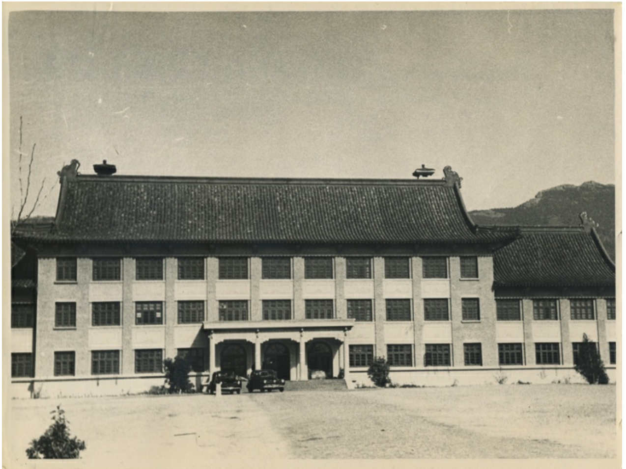
Лабораторное здание Нанкинского ботанического сада.
