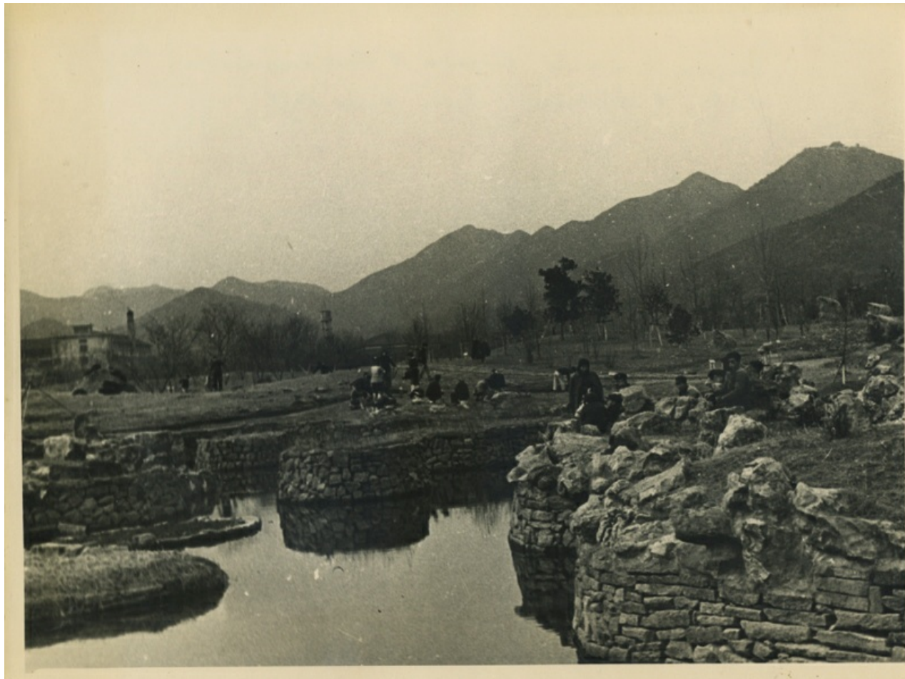
Строительство водоема в Ботаническом саду в Ханчжоу.
