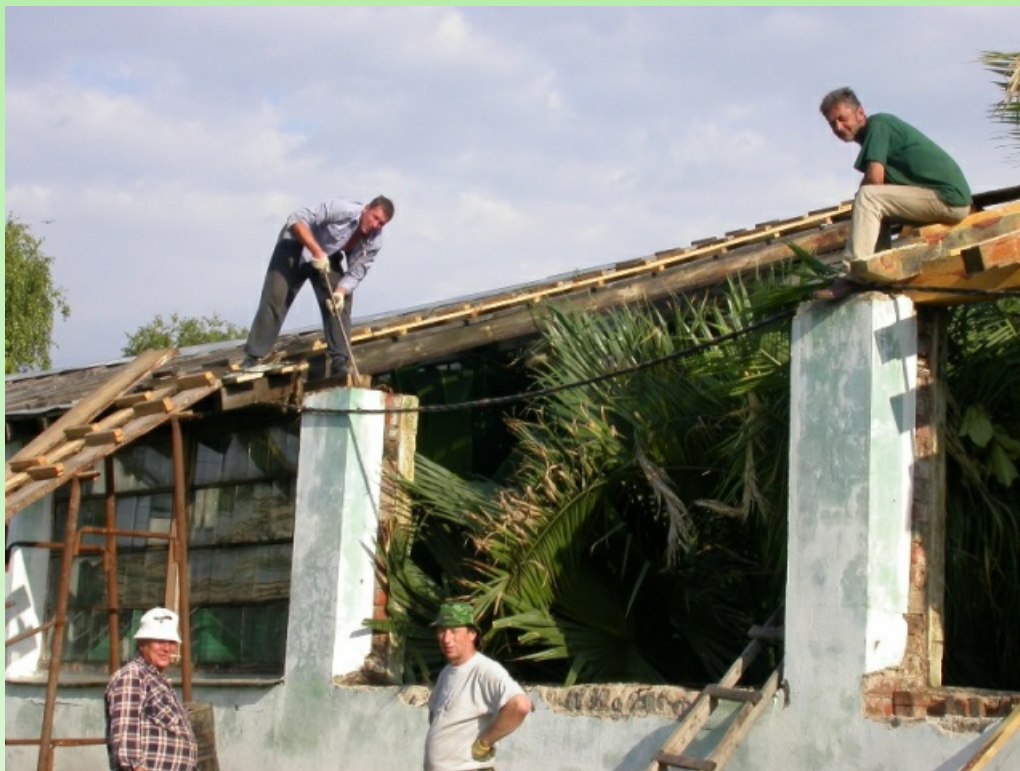
Рис. 7. Ремонт крыши, 2004 г.
