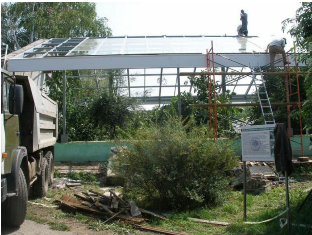
Рис. 11. Ремонт оранжереи, 2016 г.
