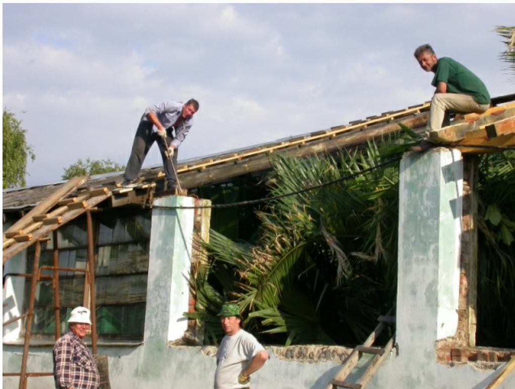
Рис. 7. Ремонт крыши, 2004 г.
