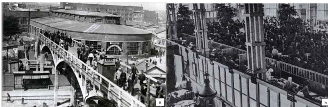
Рис. 2. Мост и вид на крышу столовой Автомобильного Московского завода (впоследствии Завод им. Сталина (ЗИС)), 1930 г. (a) «От примуса к цеху питания (завод имени Сталина, бывший АМО)», г. Москва. Из серии «От Москвы купеческой к Москве социалистической»: 1928 – 1930 (b).
