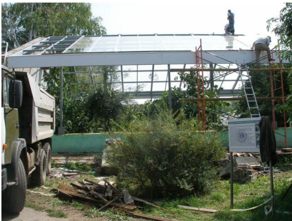
Рис. 11. Ремонт оранжереи, 2016 г.
