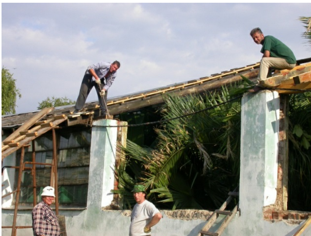
Рис. 7. Ремонт крыши, 2004 г.
