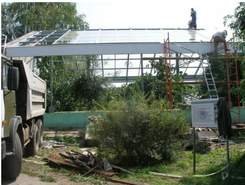
Рис. 11. Ремонт оранжереи, 2016 г.
