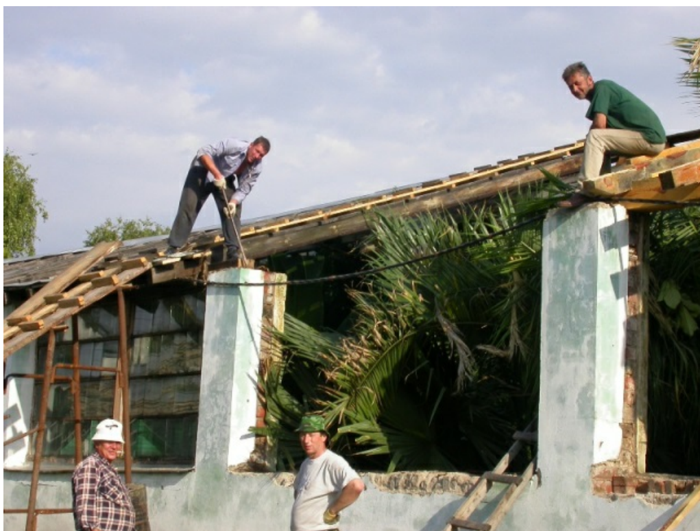
Рис. 7. Ремонт крыши, 2004 г.
