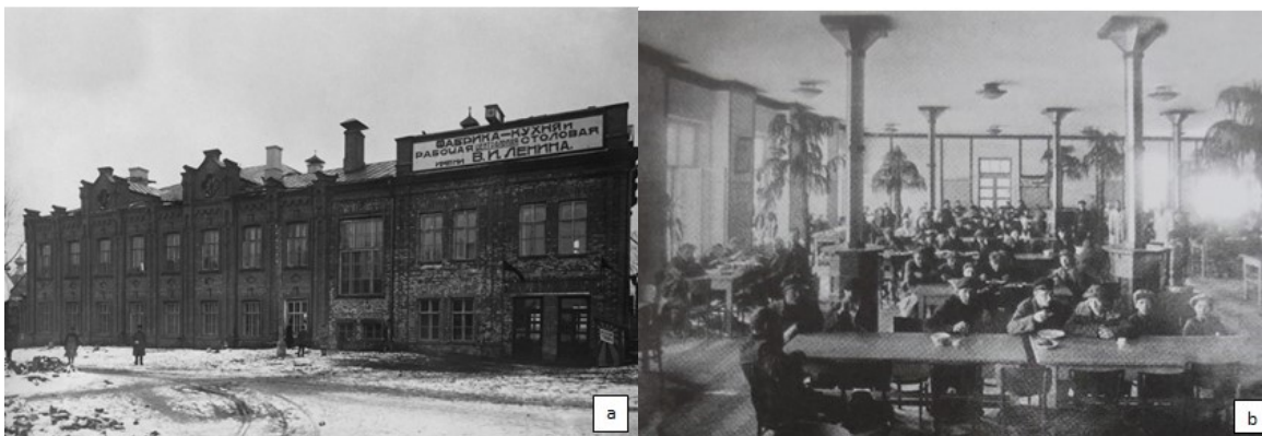
Рис. 1. Фабрика-кухня г. Иваново, 1925 г.: Внешний вид (a) и обеденный зал (b) , 1925 г.
